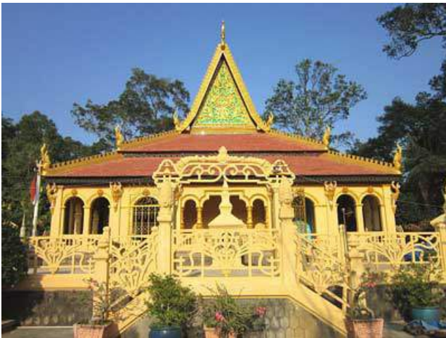
Chính điện chùa Angkorajaborey (Trà Vinh)
