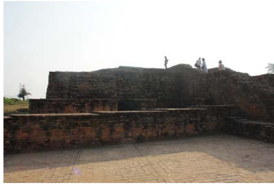
(Anathapindika Stupa in Sravasti—Tháp Ngài Cấp Cô Độc tại xứ Xá Vệ)
