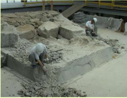
Thợ xây đục bỏ bê tông khỏi các khối đá gốc
