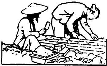
Thợ nề xây tường
